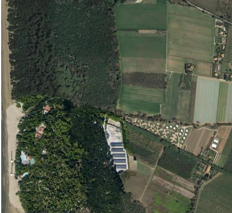
Figura 2. Tratto del Fosso Carestia oggetto di intervento (tratto delimitato dalle linee in rosso)
