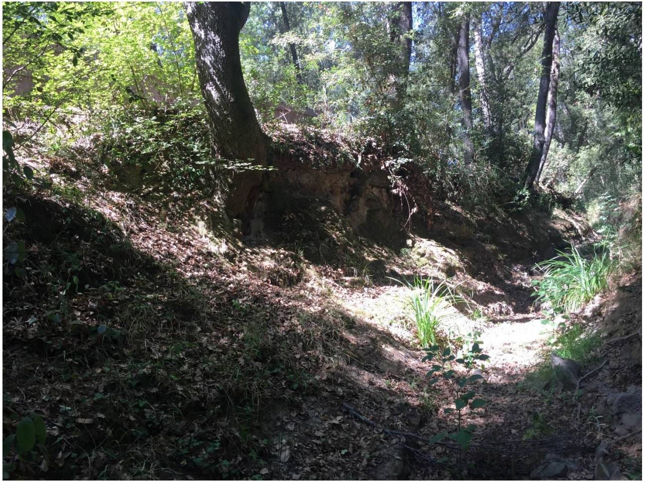
Foto 3. Fosso Carestia nel tratto oggetto di intervento
