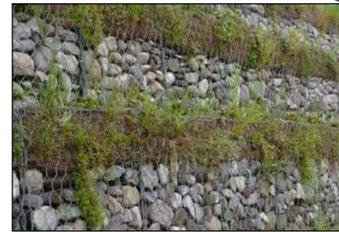
MATERASSI RENO (SOLO BASE) spessore 23 cm IN RETE METALLICA DT MAGLIA 6x8 cm diam. 2,2-3,2 mm RES. TRAZ. 37 kNm CON RIVESTIMENTO PLASTICO
